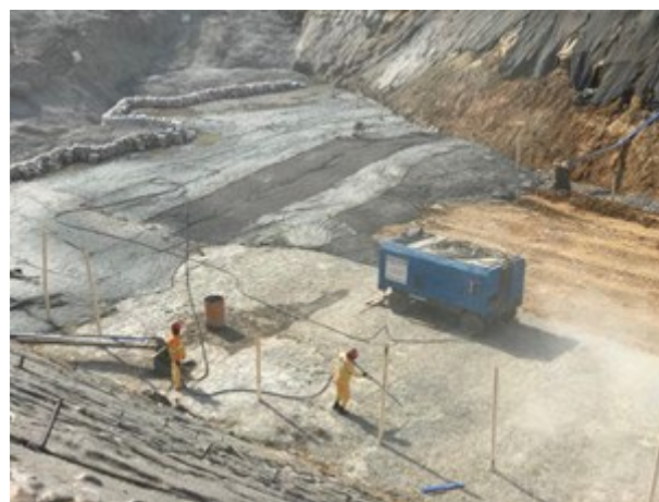
Foto 15: Atividades de concretagem na Ogiva (11/05/2022)
