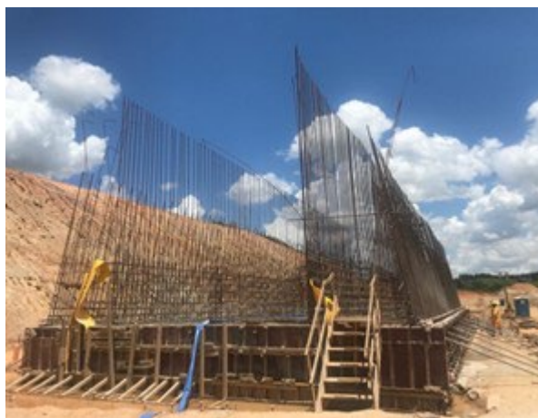
Foto 8: Vista panorâmica da galeria de desvio (17/02/2021)
