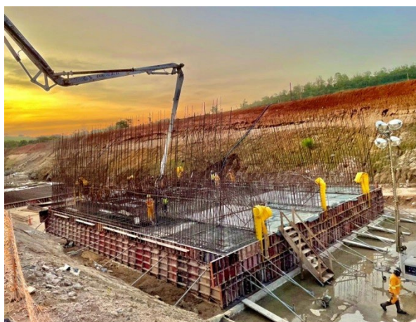
Foto 10: Vista panorâmica da galeria de desvio (29/04/2022)
