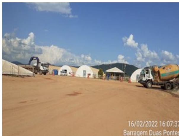
Foto 2: Vista do canteiro industrial (16/02/2022)
