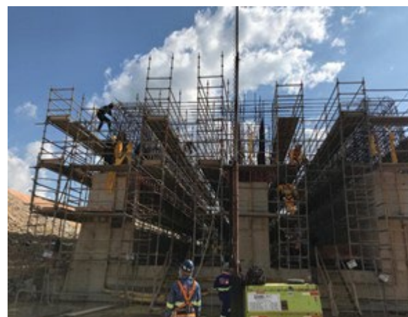
Foto 11: Vista panorâmica da galeria de desvio (10/05/2022)
