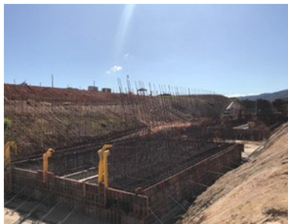
Foto 9: Vista panorâmica da galeria de desvio (30/03/2022)
