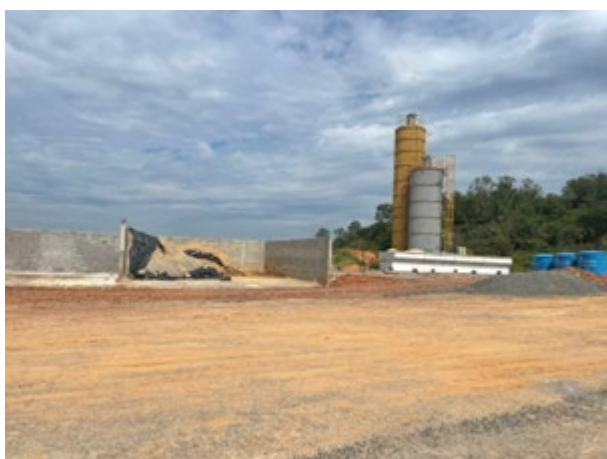
Foto 3: Vista Usina de Concreto (25/03/2022)
