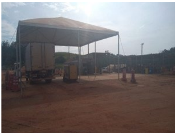
Foto 5: Oficina de apoio do canteiro industrial (12/05/2022)
