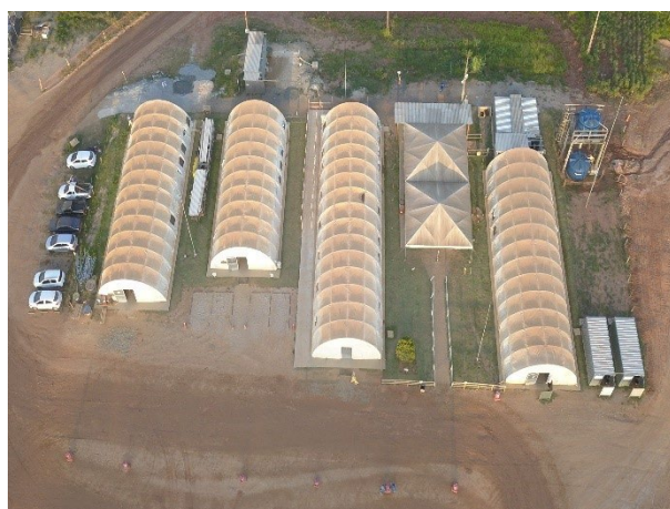
Foto 4: Vista panorâmica do canteiro industrial (22/04/2022)
