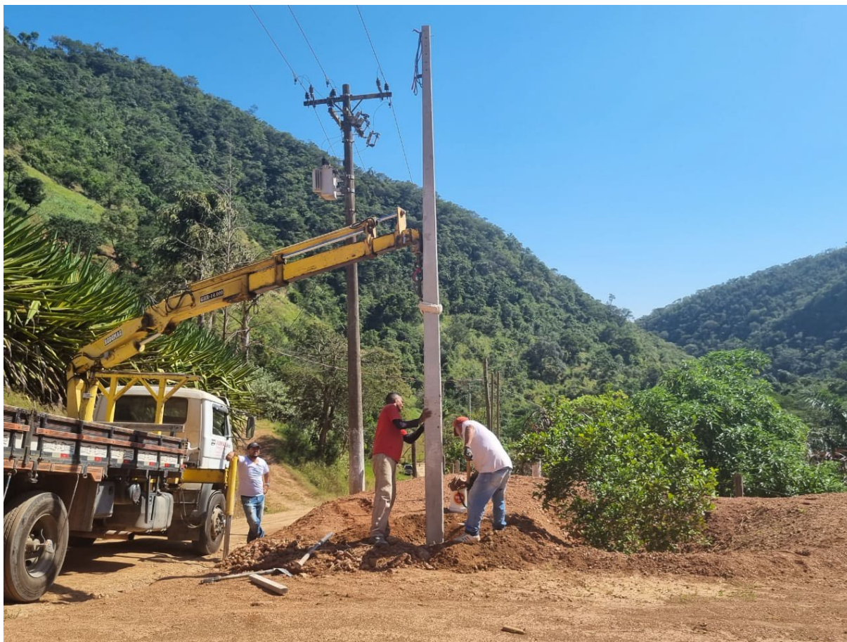
Figura 5 Instalação de poste de energia pela CPFL
