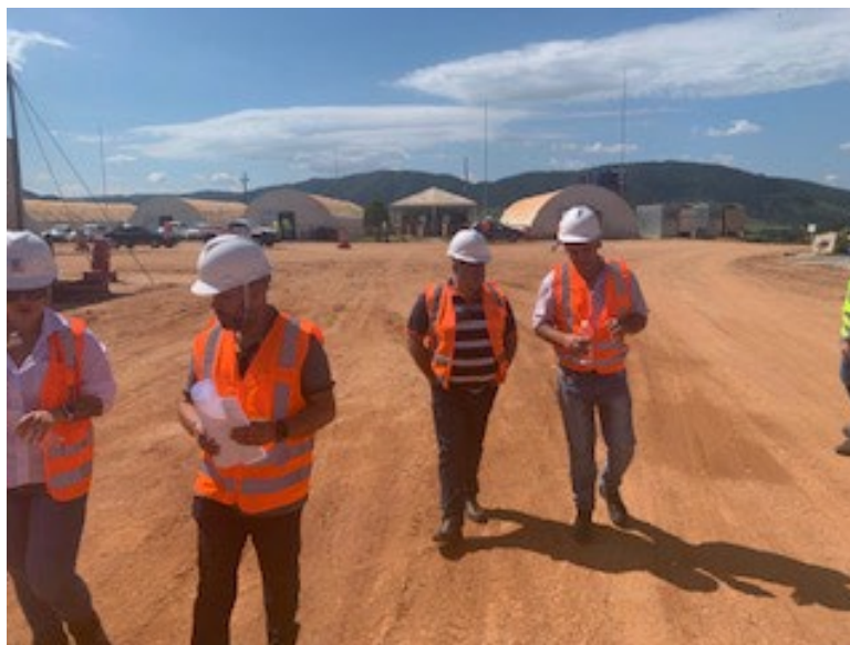
Foto 25- BDP: Visita dos membros do Comitê à obra (30/03/2022)
